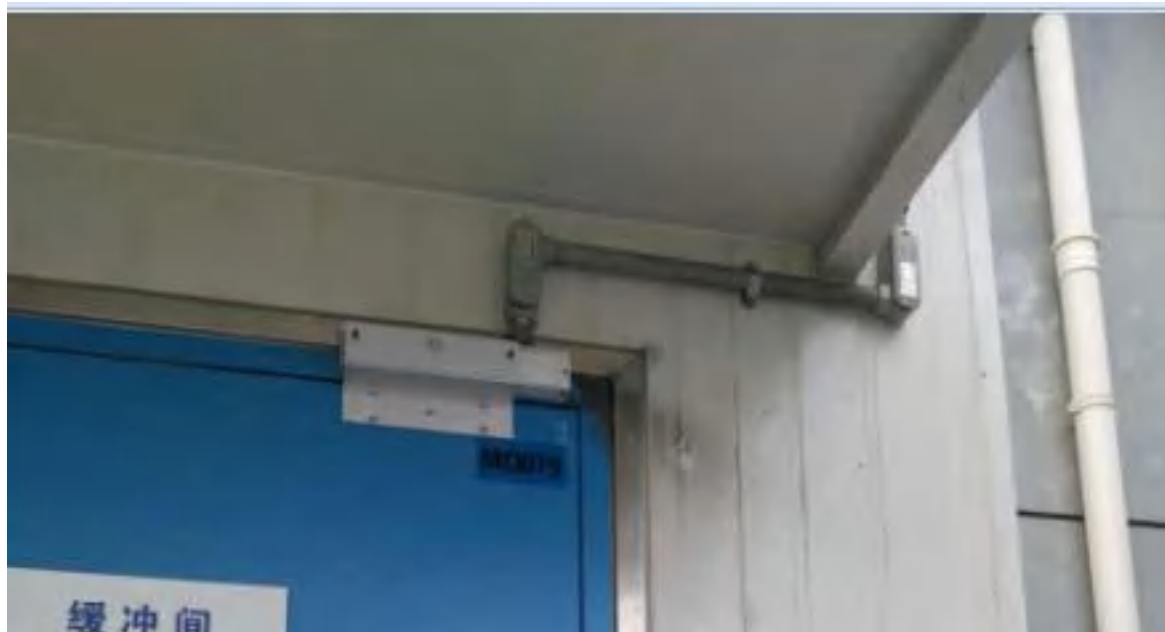
防爆区域安装防爆门禁电锁效果图
